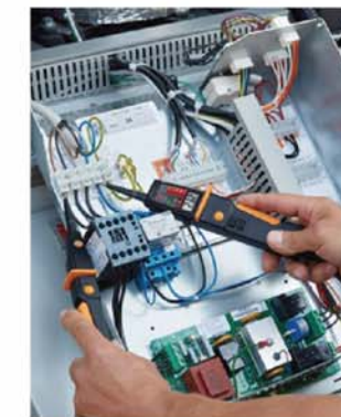
测量压缩机电压
