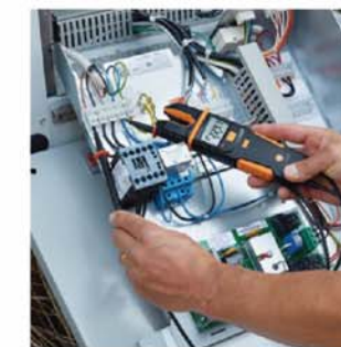
测量压缩机电压
