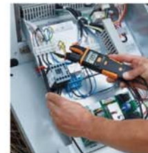
测量压缩机电压
