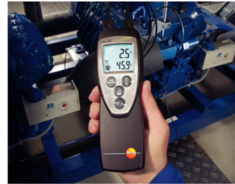
同时测量制冷设备中的过热和过冷
