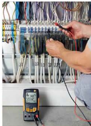
测量开关柜中的电压
